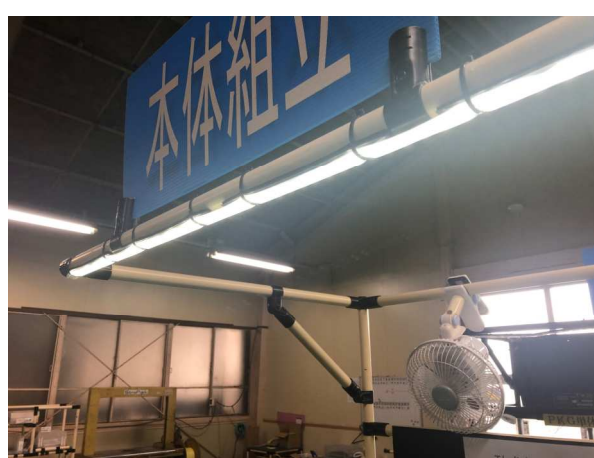
作業台照明LED化（空調換気扇部門）
